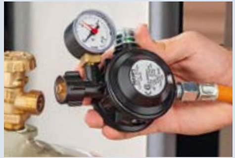
Sichtprüfung der Komponenten
