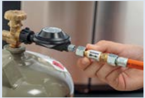
Anschluss einer Schlauchbruchsicherung an den Druckregler
