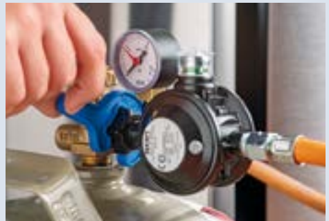
Anlage fachgerecht mit dem GOK-MiniTool montieren
